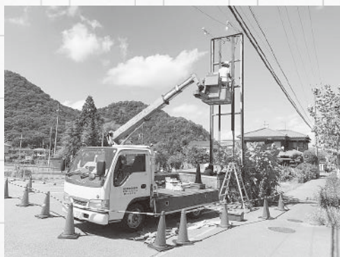
高所作業車を使った看板取り付け工事
